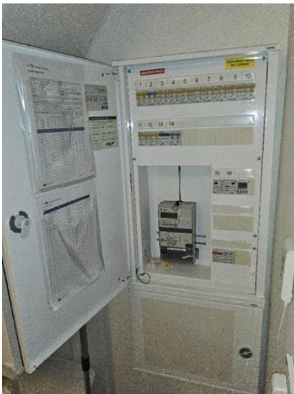
Elektrisk anlegg - [Sikringsskap med automatsikringer plassert i bod]
