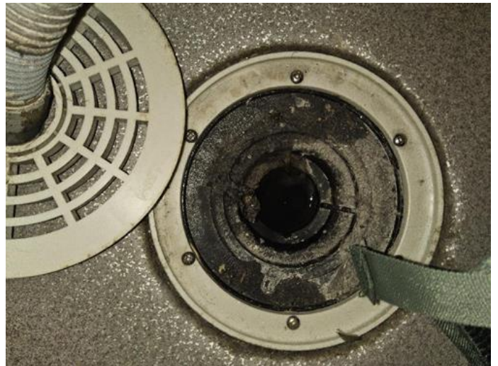
Våtrom - [Sluk vaskerom ]
