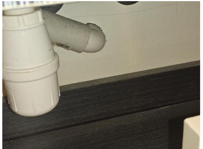
Våtrom - [Avløpsrør under servant bad 1.etg ]
