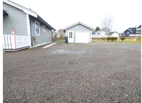
Svakt fall inn mot boligen
