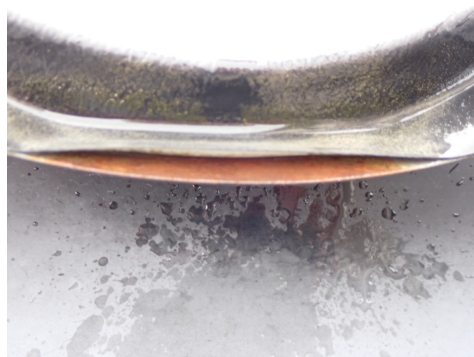
Lakk slipper helt nederst på takplater
