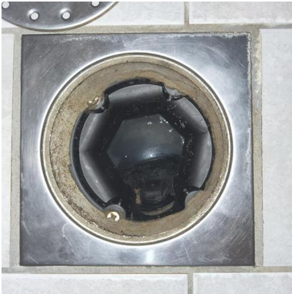
Våtrom - [Sluk bad underetasje ]
