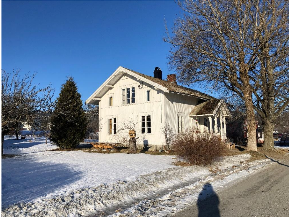
Våningshuset på Kamperhaug
