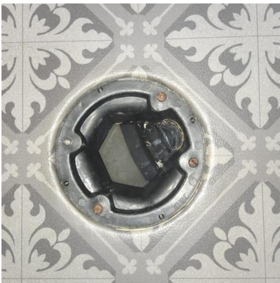
Våtrom - [Sluk bad 1.etasje ]
