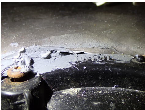
Glipp/åpning i belegg ved sluk
