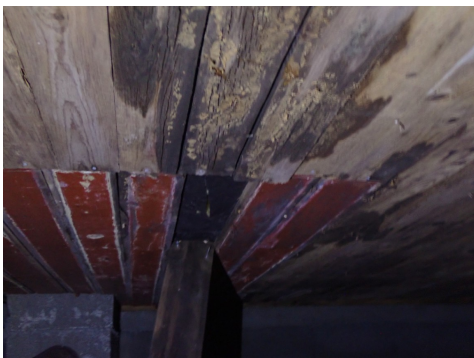
Begynnende fukt/råteskader
