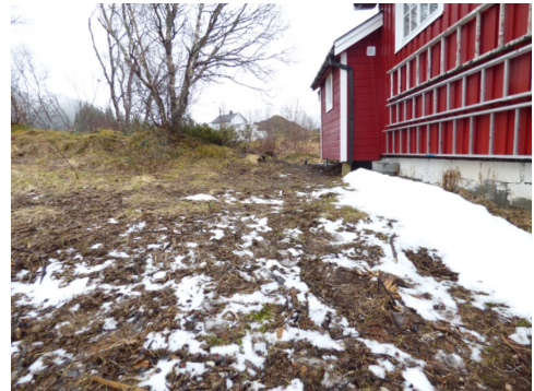
Fall inn mot deler av bygget
