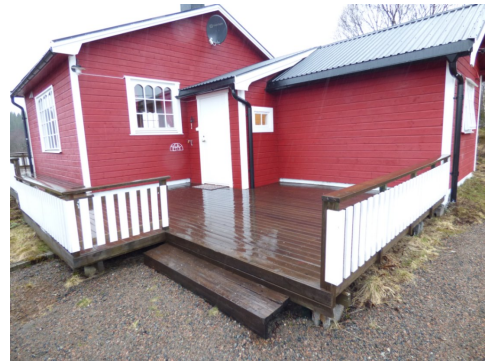
Trapp/trinn ved inngang
