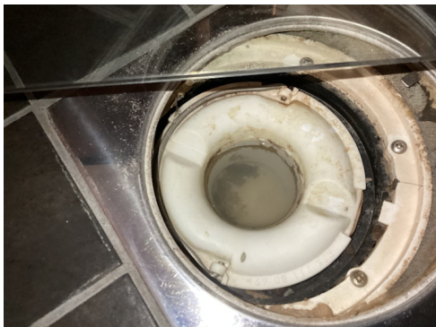
Bilde av sluk.
