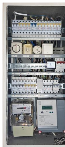
Forenklet vurdering av det elektriske anlegget - [Sikringsskap 1. etasje]
