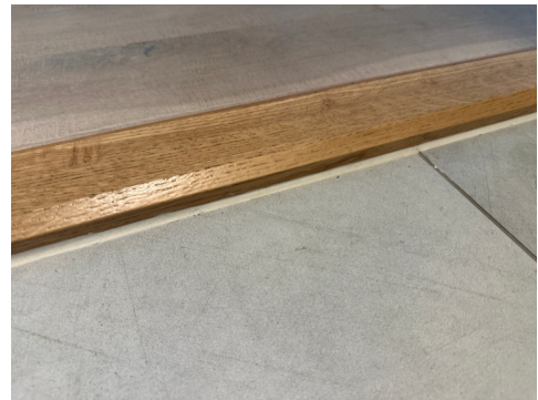
Overgang mot dørterskel.
