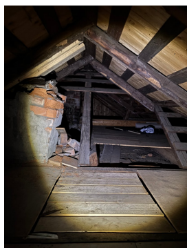
Viser deler av loft + revet gammel pipe under tak.
