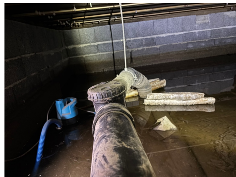
Viser avløpsrør i krypkjeller
