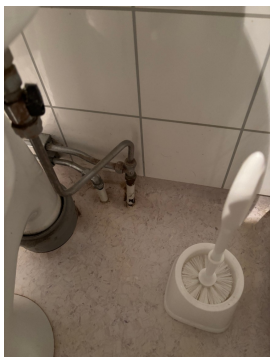
Viser rørgjennomføringer i gulv.
