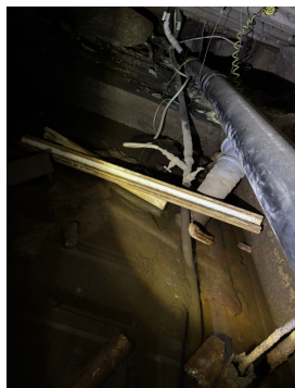
Viser vannledninger i krypkjeller.
