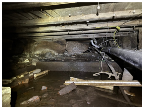
Viser avløpsrør i krypkjeller.
