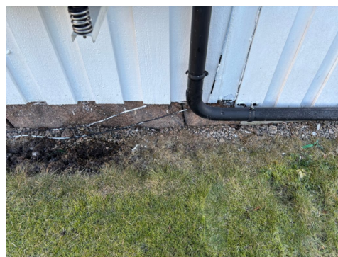
Viser deler av kledning i skjøt mellom gammelt bygg og tilbygg
