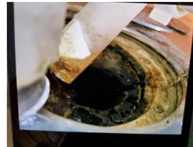
Membran, tettesjikt og overgang til sluk. - [Sluk i bad annes.]
