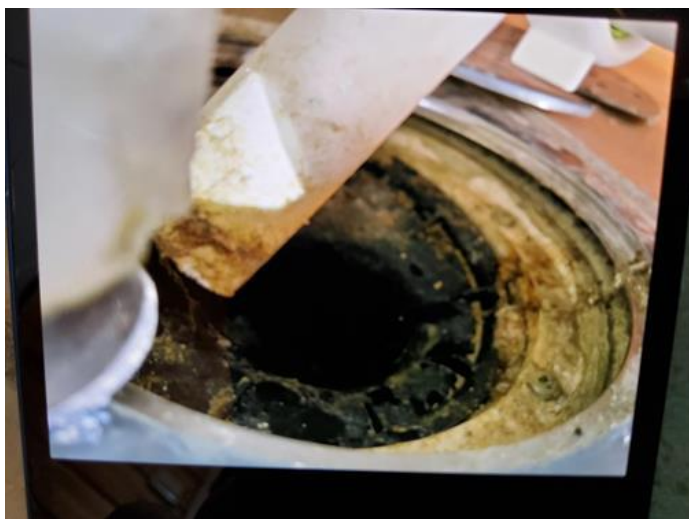
Membran, tettesjikt og overgang til sluk. - [Sluk i bad anneks.]
