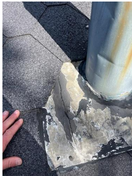
Takgjennomføringer - [Beslag rundt kloakkluftig. ]
