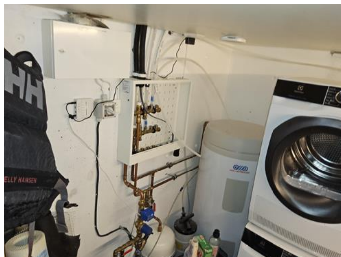
Tekniske anlegg, VVS anlegg (Sjekkpunkter utover det som er inkludert i andre rom) - [Vannskap, VVB hovedstoppekran.]
