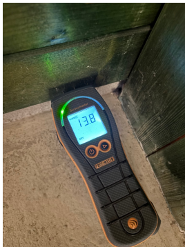
Viser fuktmåling i vegg mot bad.
