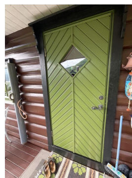
Panelt ytterdør med glass til balkongen.
