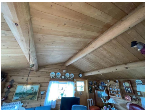
Åstak med rundtømmer som bæring.
