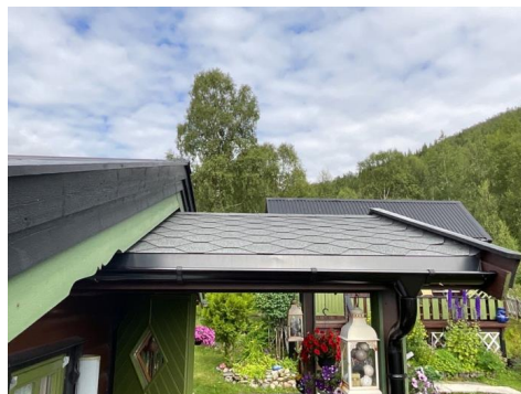
Pappshingel over taket ved inngangen.
