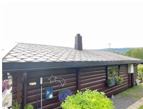
Skiferstein som taktekke på hoveddelen.
