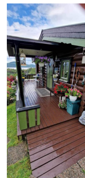
Takoverbygd treplating foran hovedinngangen.
