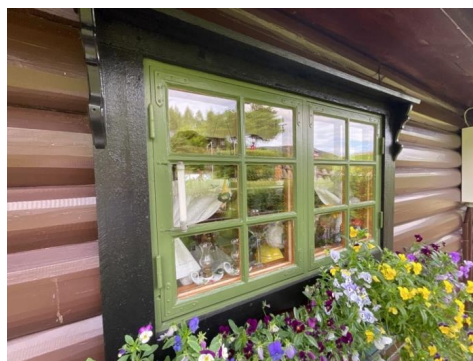
Kjøkkenvinduet er med kobla glass fra byggeåret.
