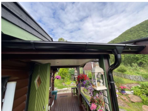
Stålrenner på takoverbygget ved inngangen.
