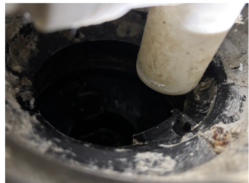
Viser rørgjennomføringer
