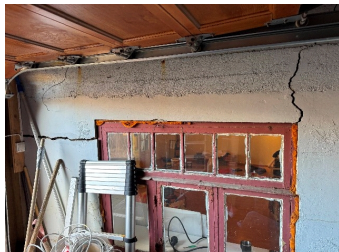
Vegg mellom garasje og atelier
