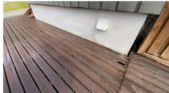
Oversikt mur tilbygg ved terrasse
