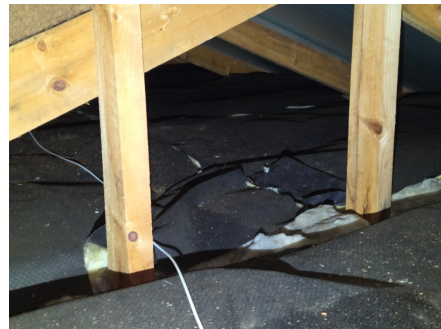
Kontroll av takkonstruksjon av tilbygg er ikke utført grunnet lav tilkomst.
