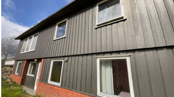
Vinduer på soverom fra 1999
