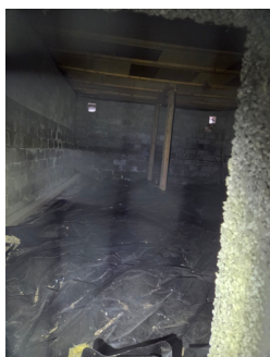
Oversikt inn i krypkjeller under tilbygg ved kjøkken. Synlig dampspærre mot grunn. Det er montert netting mot inspeksjons åpning
