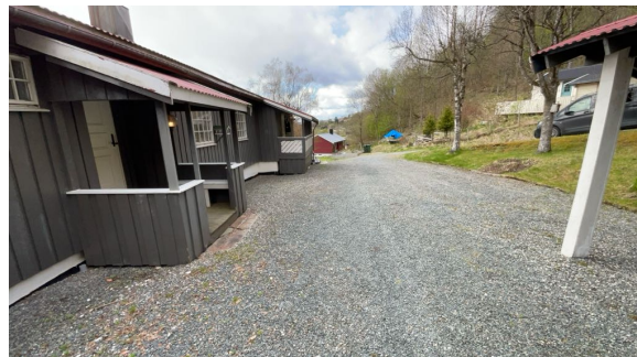
Fall på terreng ovenfor boligen mot bolig med risiko for at vann trenger inn i boligen
