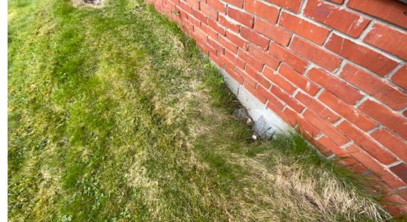
I front av boligen er det ingen synlig grunnmursplast
