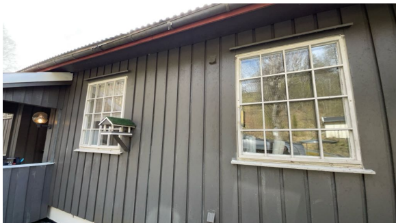
Koblede vinduer på kjøkken og stue fra byggeår
