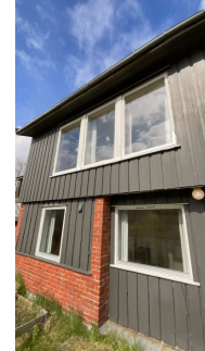
Koblede vinduer i stue 1. etasje fra byggeår og 2-lags vindu på stue i underetasjen fra 1999
