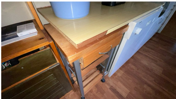
Mangler deler av kantlist på benkeplate.
