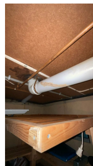
Sprekk i avløpsrør på bod er tettet
