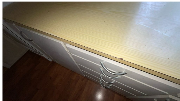
Skade på benkeplate
