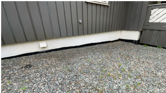
Oversikt mur overside
