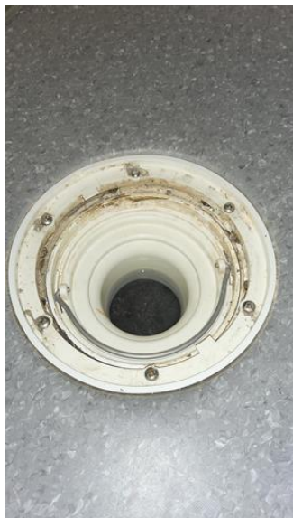
Avløpsrør (ink. sluk) - [Sluk bad ved entre]
