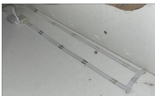
Figur 4 Automatisk vannavstengingsventil og sensorledning
