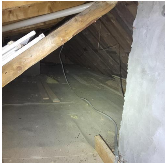
Loft - uinnredet / råloft - [Loft]
