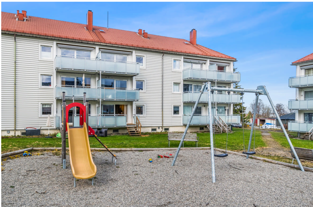
Lekeplass og stort grøntareal mellom byggene.
