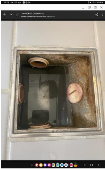
Våtrom - [Sluk ved toalett bad]
