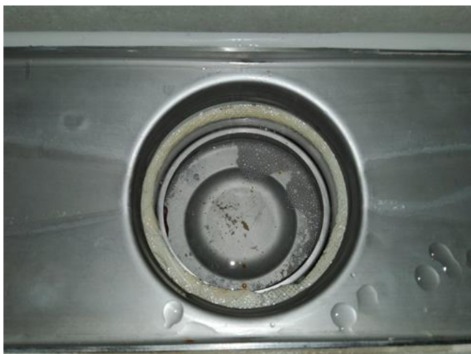
Membran, tettesjikt og overgang til sluk. - [Sluk]
