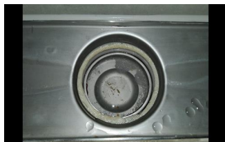
Tettesjiktets tilslutning til sluk - Sluk
