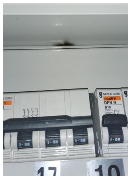
Forenklet vurdering av det elektriske anlegget - [Svimerke i sikringsskap]
