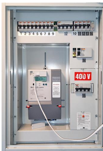
Forenklet vurdering av det elektriske anlegget - [Sikringsskap]
