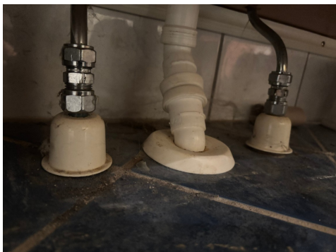
Viser rørgjennomføringer.
