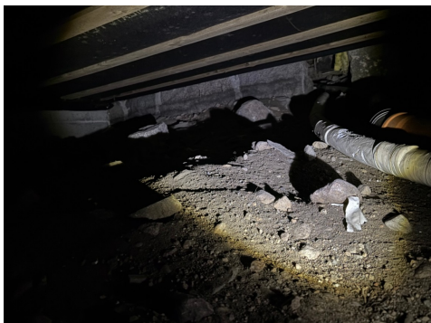
Viser deler av krypkjeller
