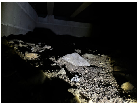
Viser deler av krypkjeller
