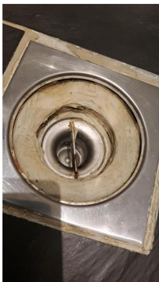
Våtrom - [Sluk bad']
