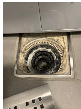
Viser sluk. (ikke sentrisk under slukrist)
