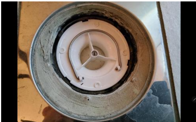
Membran, tettesjikt og overgang til sluk. - [Sluk vaskerom ]
