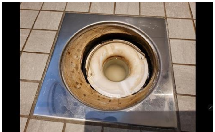
Membran, tettesjikt og overgang til sluk. - [Sluk bad 2]
