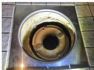
Tettesjiktets tilslutning til sluk - Sluk i bad 1.
