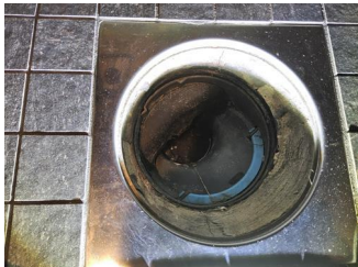
Tettesjiktets tilslutning til sluk - Sluk i bad 2.
