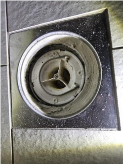
Tettesjiktets tilslutning til sluk - Sluk i vaskerom
