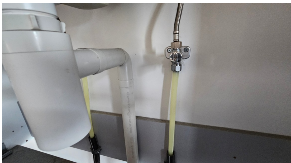
Kontroll av røropplegg.
