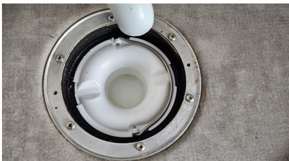
Kontroll av sluk.
