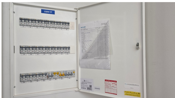
Kontroll av el-skap.
