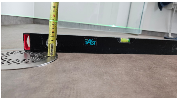
Kontroll av fall mot sluk.
