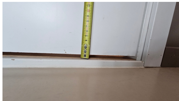
Kontroll av høyde på luftespalte under døren.
