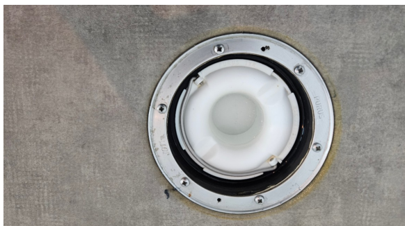
Kontroll av sluk.
