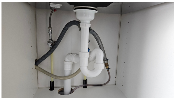
Kontroll av røropplegg.
