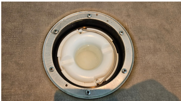
Kontroll av sluk.
