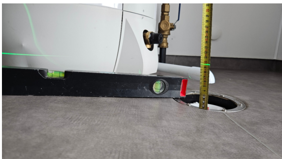
Kontroll av fall mot sluk.
