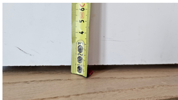
Kontroll av høyde på luftespalte under døren.
