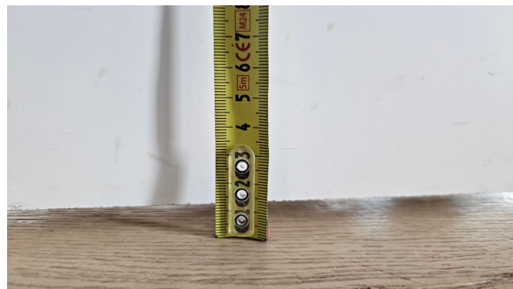
Kontroll av høyde på luftespalte under døren.
