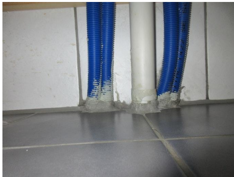
Rørgjennomføringer i gulv.
