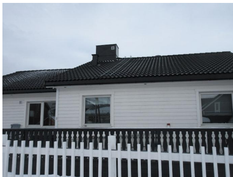
Taktekking med takstige.
