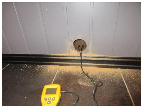
Fuktsøk mot våtsone på bad.
