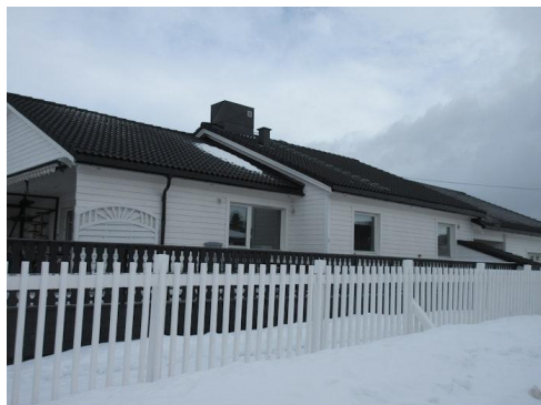
Taktekking, betongstein.
