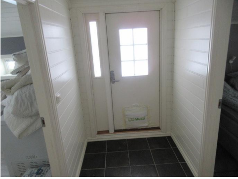
Kattehull i dør i sokkeetasjen.
