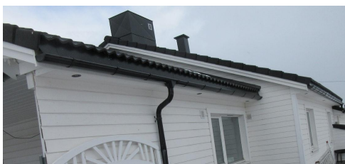
Takrenner og nedløp.
