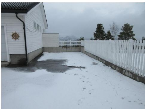
Forstøtningsmur i betong for parkeringsplass med rekkverk på toppen.
