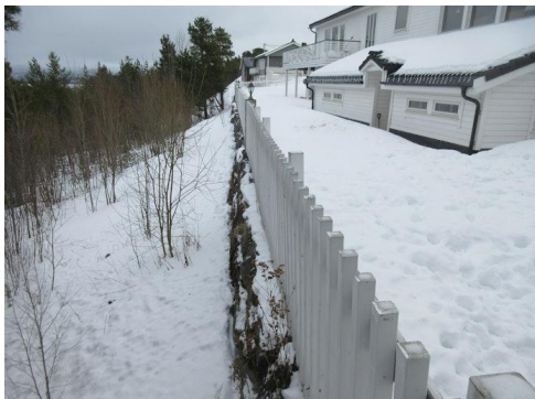
Forstøtningsmur med rekkverk. Forstøtningsmur som tørrmur i skifer.
