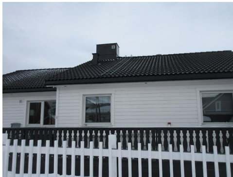
Taktekking med takstige.
