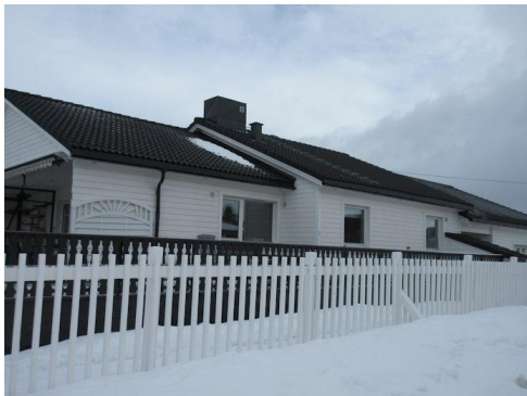
Taktekking, betongstein.
