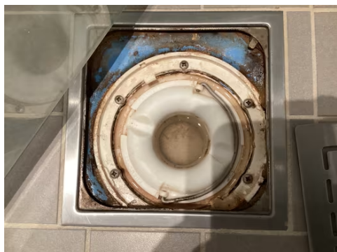
Baderomssluk plassert i dusjsonen.
