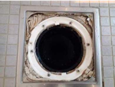
Membran, tettesjikt og overgang til sluk. - [Sluk i baderom i 1 etasje. ]
