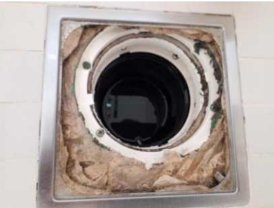
Membran, tettesjikt og overgang til sluk. - [Sluk i baderom i 2 etasje. ]
