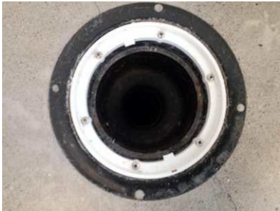
Tekniske anlegg, VVS anlegg [Sjekkpunkter utover det som er inkludert i andre rom] - [Sluk i vaskerom/teknisk rom.]
