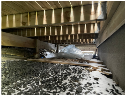
Bilde fra øverside under inngangsparti
