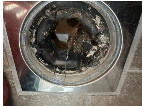
Sluk i gulv på vaskerom.
