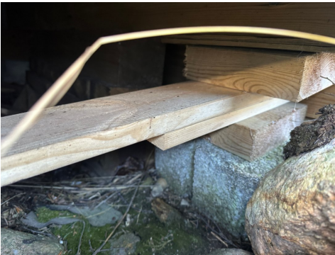
Oppbygd fundament ved påbygg.
