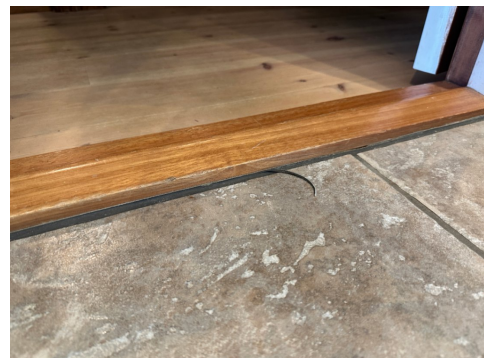
Overgang mot dørterskel.
