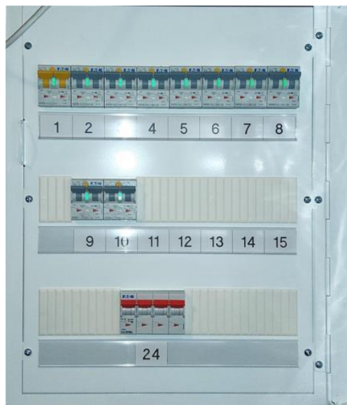
Forenklet vurdering av det elektriske anlegget - [Sikringsskap leilighet]
