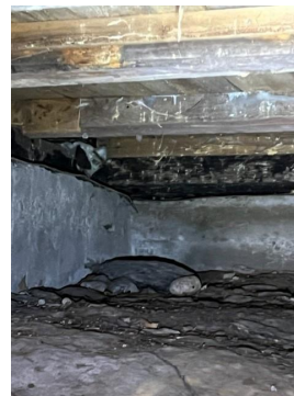
Synlig aktivitet av stripet bore biller i bjelkelag ned mot kryp kjeller.
