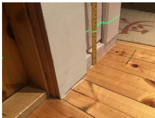
ikke funnet større høydeforskjeller i bjelkelag
