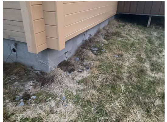
grunnmur ingen riss eller sprekker funnet
