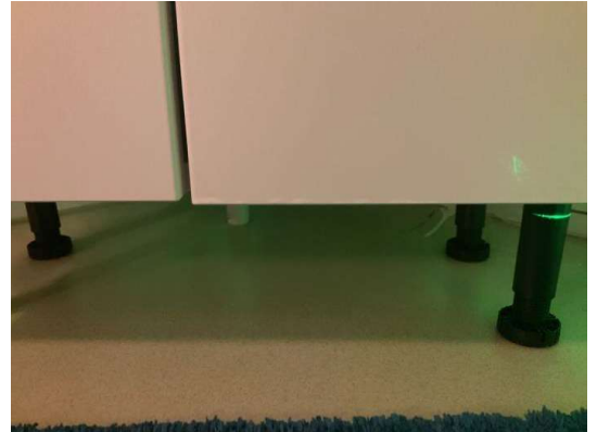
mindre fuktskade på fronter innredning
