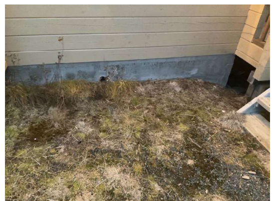
grunnmur ingen riss eller sprekker funnet
