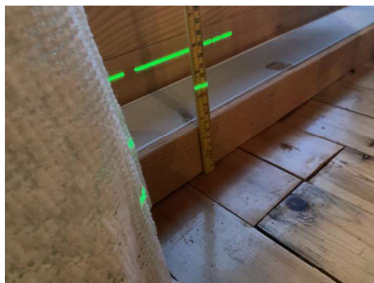
ikke funnet større høydeforskjeller i bjelkelag
