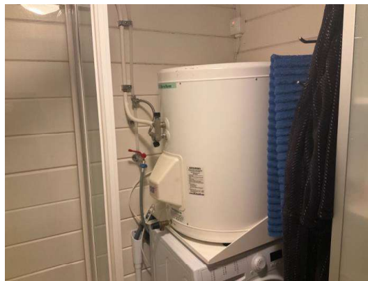
varmtvannstank 115 liter
