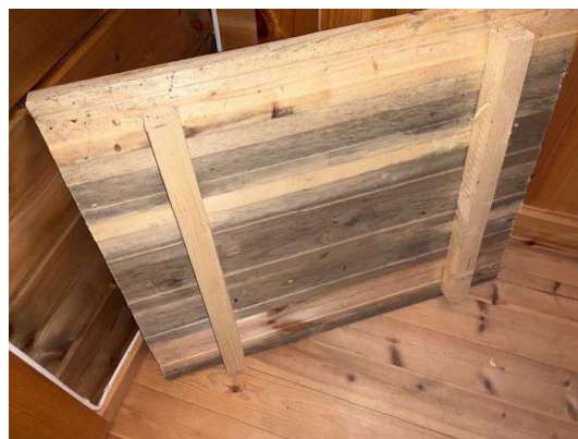
luke ned til krypkjeller bør isoleres og tettes.
