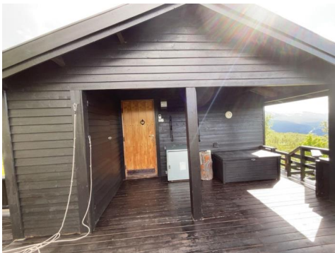
Kledningen ved inngangspartiet er av eldre dato, men i bra stand.
