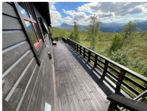
Del av balkongen, bilde II
