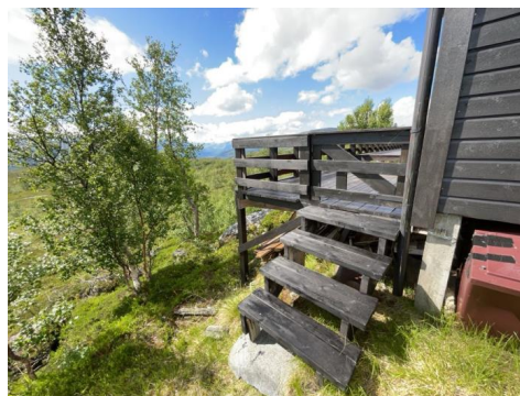
Tretrapp fra balkongen på østsiden.
