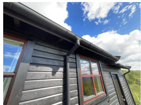
Takrenner og nedløp i stål.
