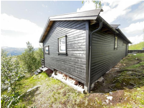
Utvendig liggende bordkledning fra 2021/2022 på 3 av ytterveggene.
