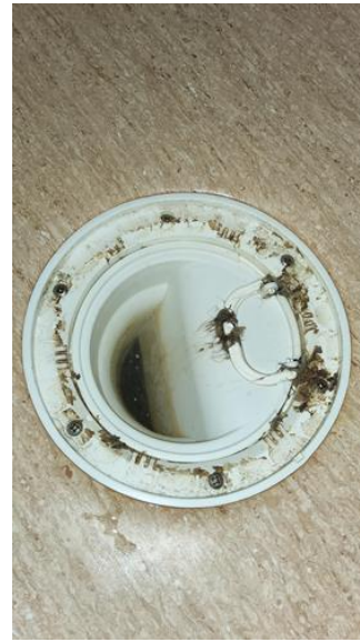
Avløpsrør (ink. sluk) - [Sluk dusj]
