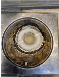
Membran, tettesjikt og overgang til sluk. - [Sluk]
