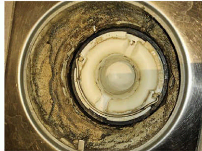
Membran, tettesjikt og overgang til sluk. - [Sluk]
