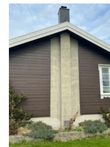
Feierluke er installert utvendig.
