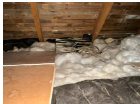
Isolasjon av glassvatt på kaldloft.
