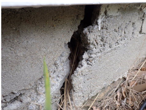
Sprekker i ringmur under tilbygget
