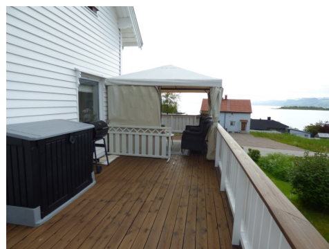
Del av veranda mot nordvest
