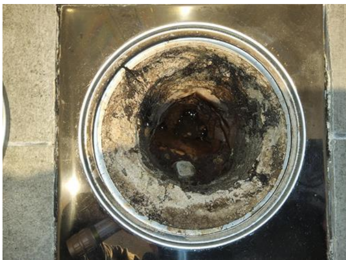
Membran, tettesjikt og overgang til sluk. - [Sluk på baderom i underetasje]
