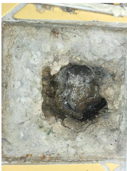
Membran, tettesjikt og overgang til sluk. - [Sluk på baderom i 1.etasje]
