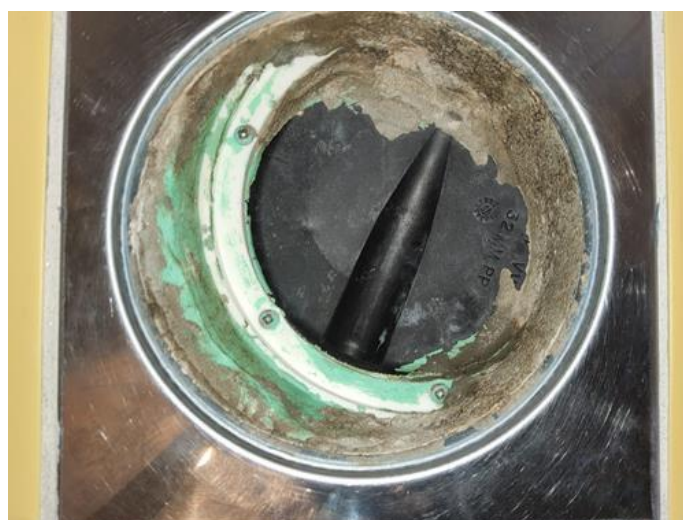
Membran, tettesjikt og overgang til sluk. - [Hjelpesluk i dusj på baderom i 1.etasje]
