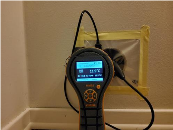
Kommentar - [Fuktmåling bad.]
