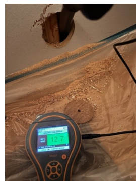
Fuktmåling i vegg mot våtzone.
