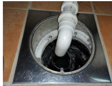
Membran, tettesjikt og overgang til sluk. - [Sluk i vaskerom. ]
