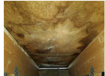
Overflater vegger/undertak - [Undertak over ventilasjonsaggregat på kaldtloft. ]
